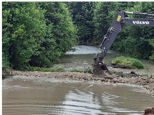
Mise en place de batardeaux à l'amont et à l'aval du tronçon
