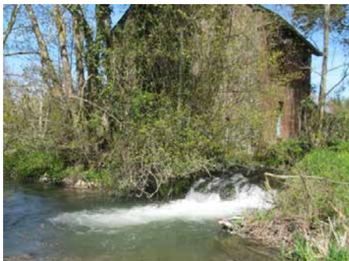
Seuil du moulin avant travaux
