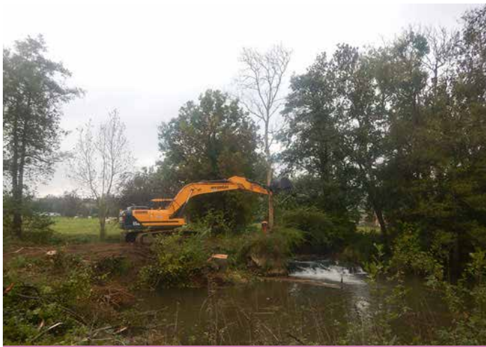
Abbatage des arbres se trouvant sur le nouveau tracé de la rivière
