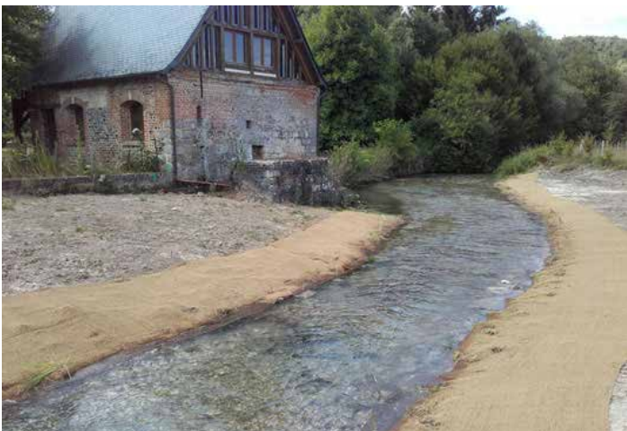
Terrassement, mise en place de géotextile et plantation d'hélophytes
