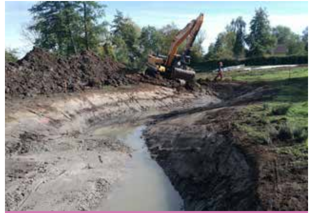
Terrassement du nouveau bras
