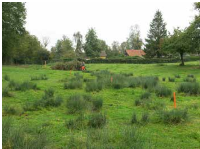
Piquetage du nouveau bras de rivière
