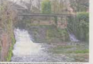
Vue de la nouvelle structure de passage à poissons sur la Varenne. (Photo de Yannick Bouchard)
