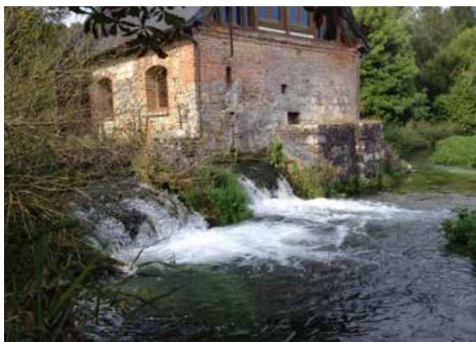
Seuil du moulin avant travaux
