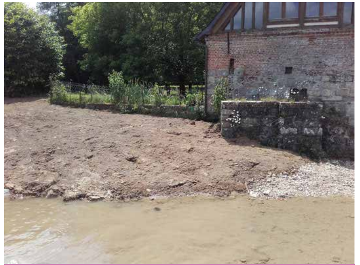
Moulin après suppression du seuil
