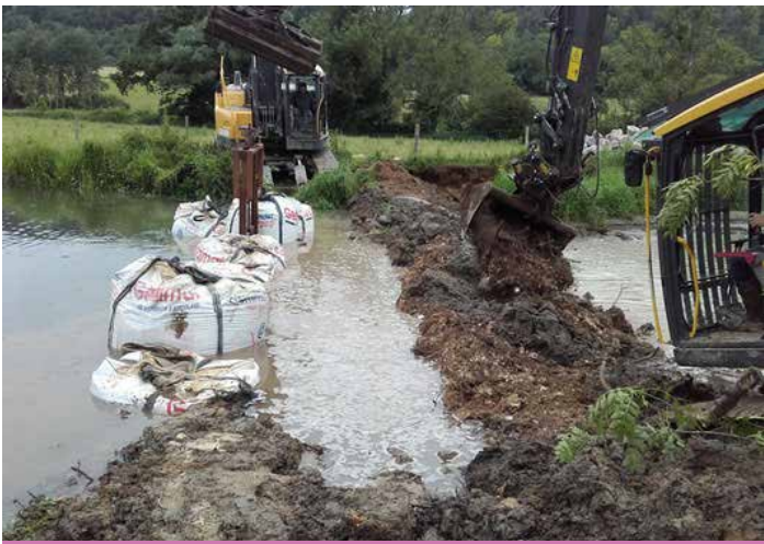
Mise en place du batardeau pour mise à sec du tronçon à reprofiler
