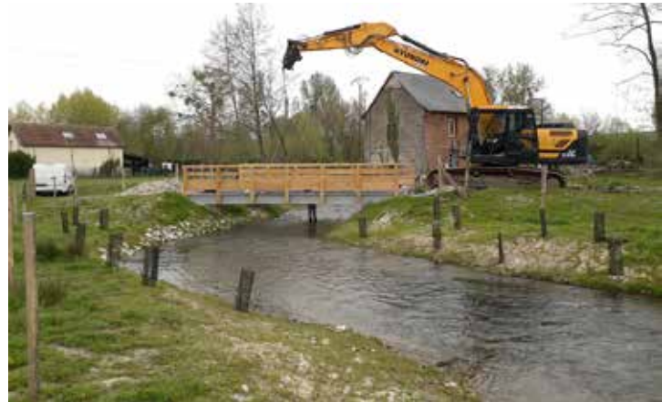
Installation de la passerelle
