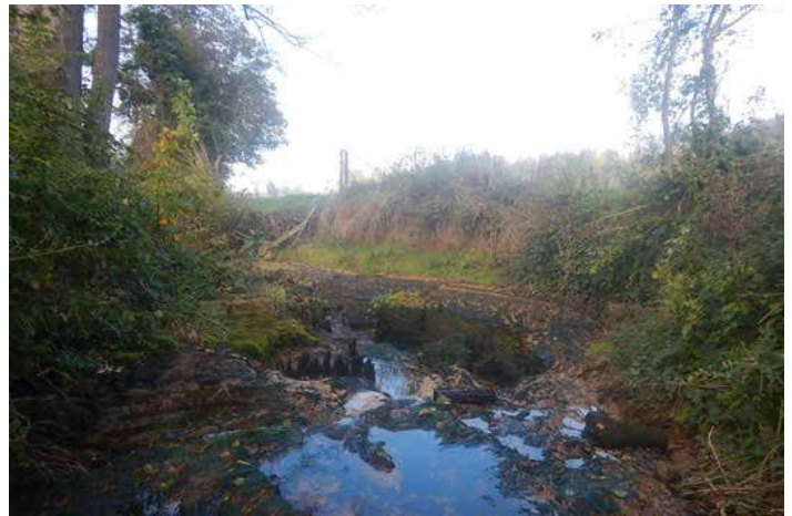
Reprofilage des berges et rétablissement des écoulements au niveau des deux bras de la rivière
