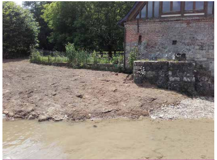
Moulin après suppression du seuil
