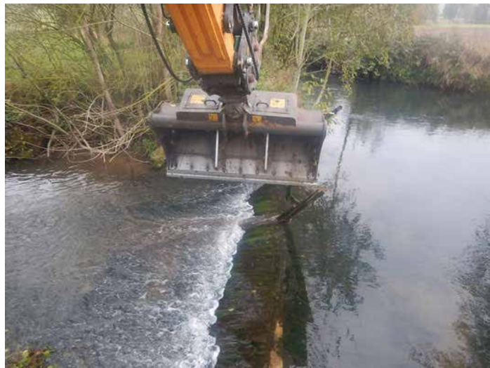
Démolition des maçonneries du seuil
