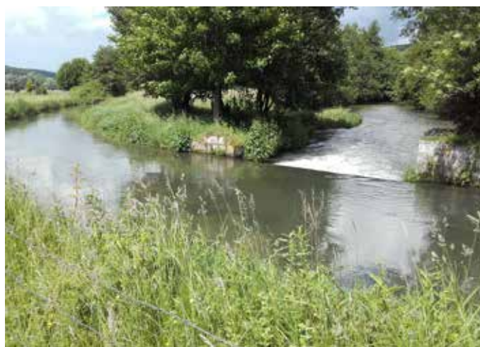
Ouvrage de répartition avant travaux
