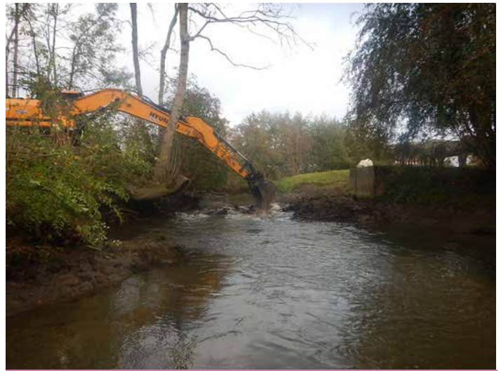
Démolition des maçonneries du seuil
