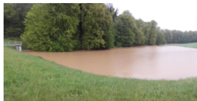
Ouvrage d'une capacité de 30 000 m³ quasiment plein à Muchedent
