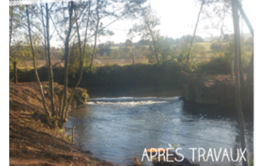
Site du vannage répartiteur de Bures-en-Bray
