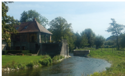
Site du moulin de Saint-Aubin-le-Cauf après travaux
