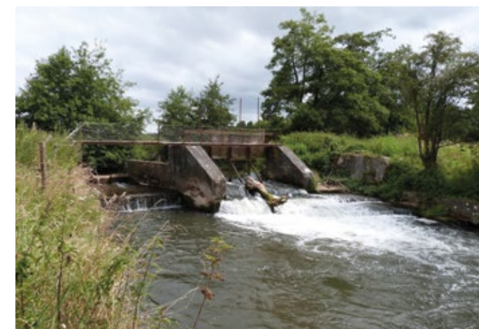
Vue de l'ouvrage répartiteur avant travaux
