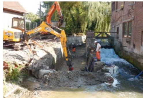
2-Terrassement du fond de forme de la passe
