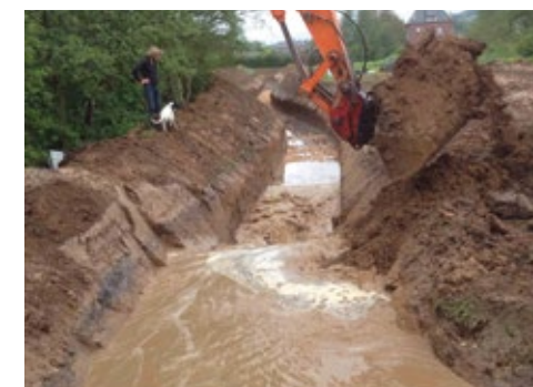
3 - Création d'un bras temporaire de dérivation des eaux
