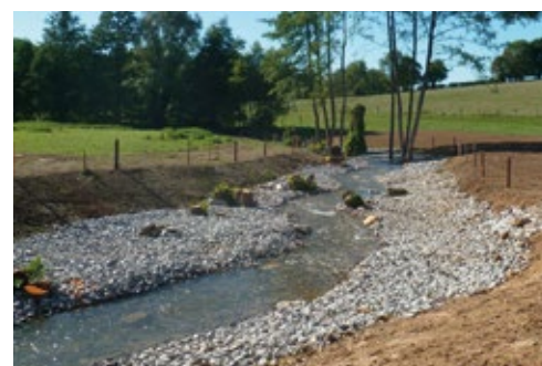
Fin des travaux, continuité écologique restaurée
