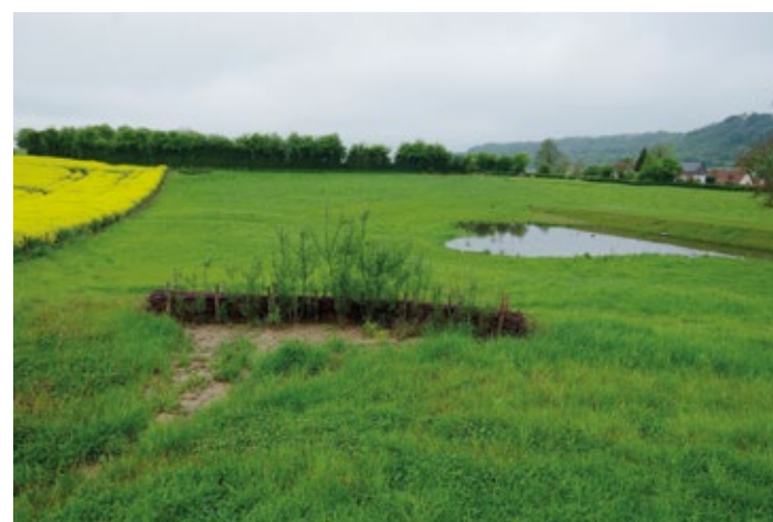
Ouvrage (prairie inondable avec fascine à l'entrée) – Saint-Ouen-sous-Bailly
