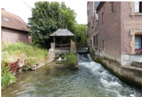
1-Chute du moulin d'Archelles avant travaux
