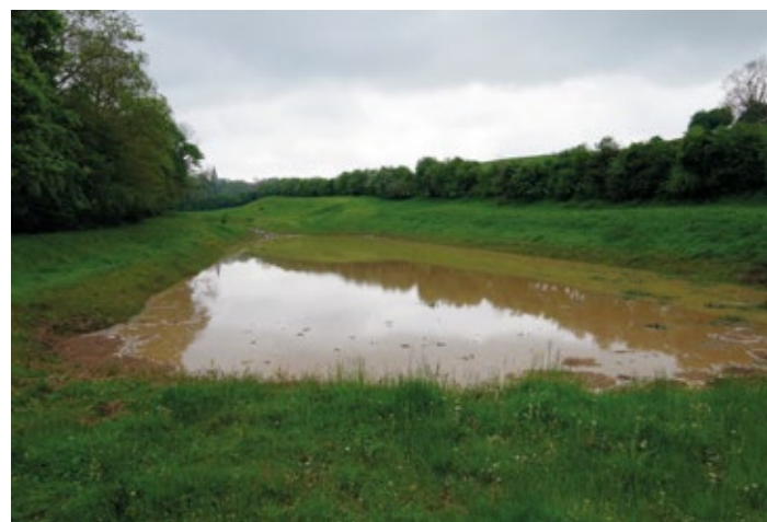
Ouvrage (bassin de rétention) – Petit-Caux
