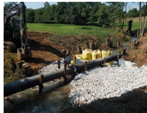
Recharge granulométrique du fond du lit et création du 1 er seuil
