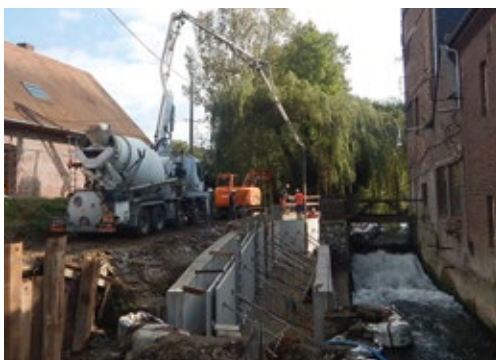
3- Mise en place des pré-fabriqués béton
