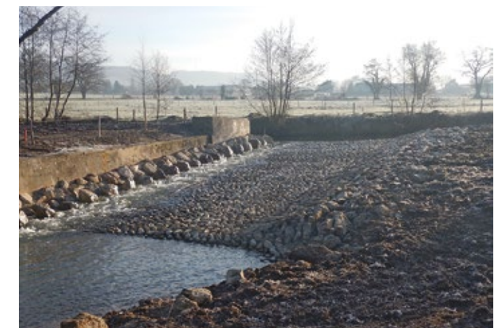
Vue de la rampe en enrochement en fonctionnement
