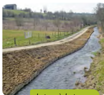
Juste après les travaux
