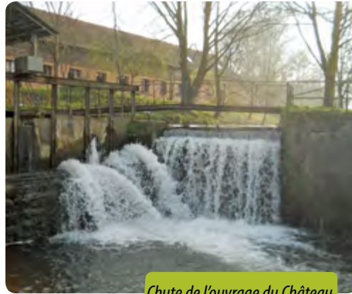
Chute de l'ouvrage du Château de Mesnières-en-Bray
